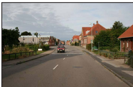
Overkørsel 45 for Østerled/Ulstrupvej.
