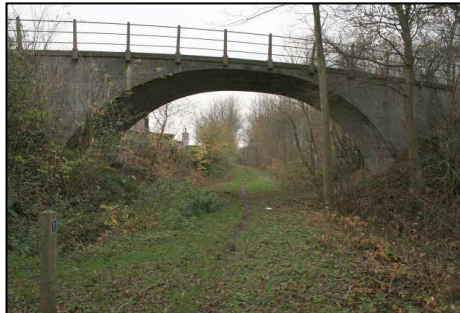
Bro over Tjørnhøjvej, km 19,1.
