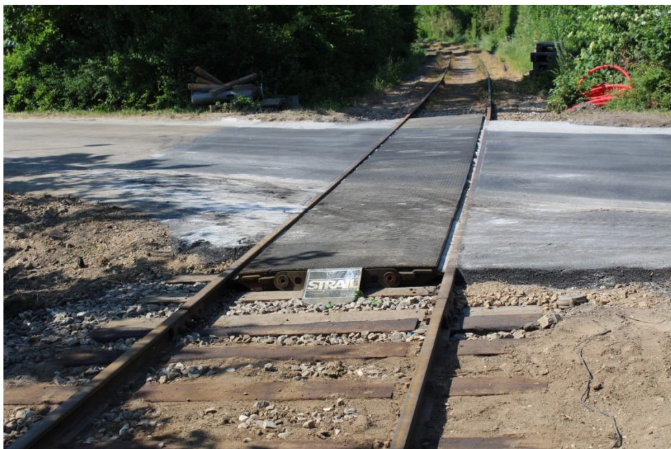
Figur 9 Nye sveller og ny vejbelægning i Tranevej 2018
