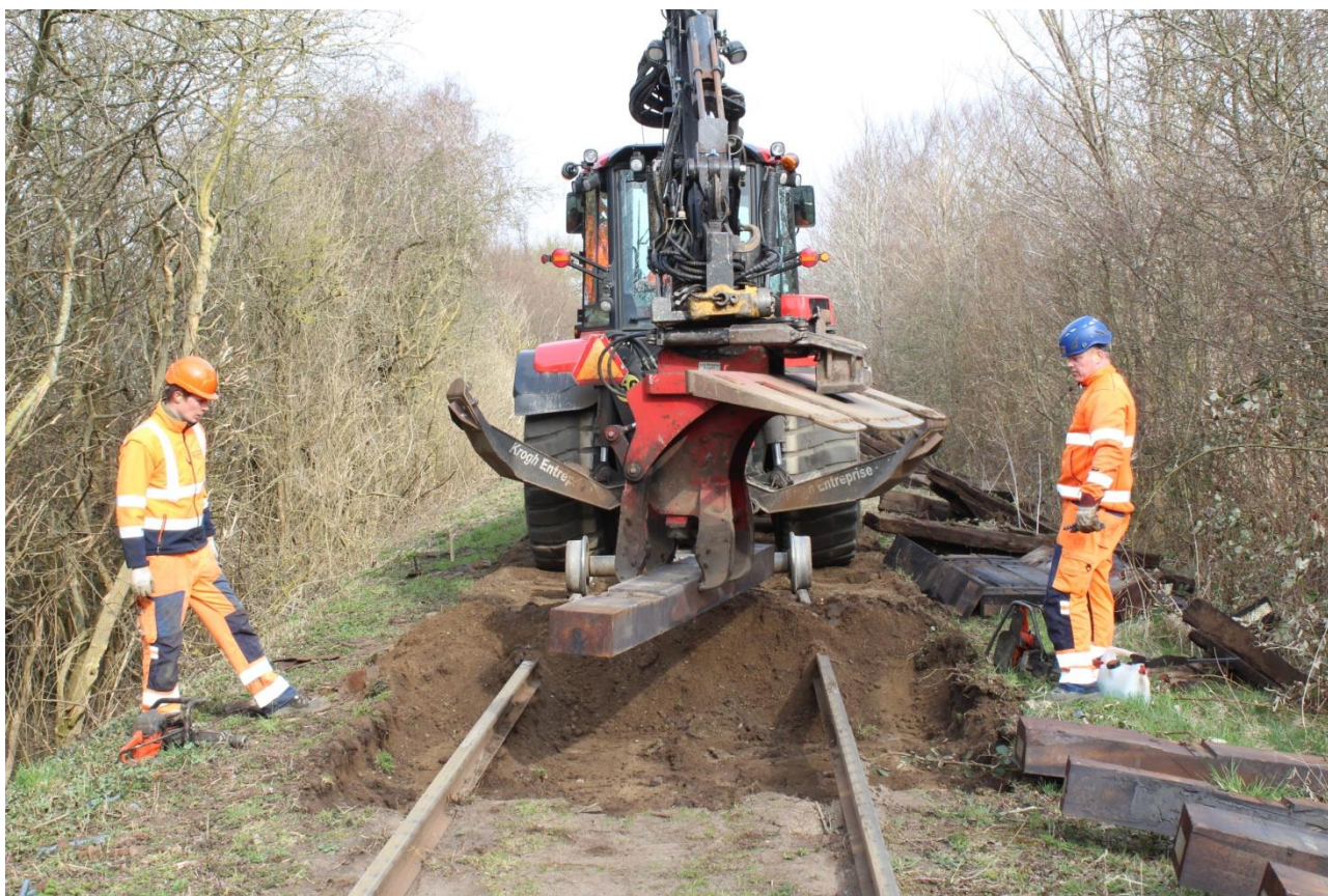
Figur 8 Udskiftning af sveller ved Høng 2018
